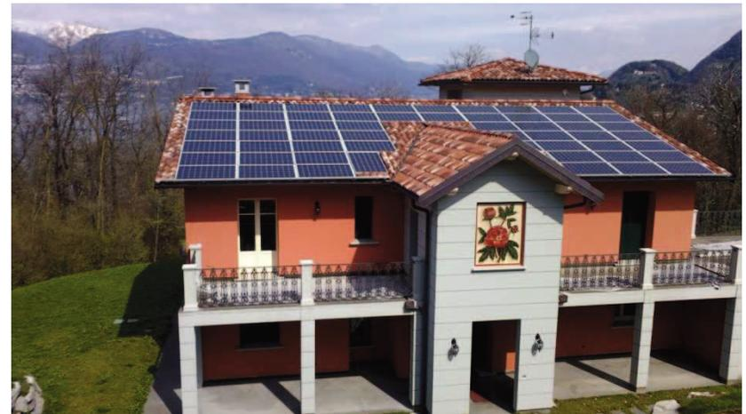
L'impianto fotovoltaico è stato previsto con lo scambio sul posto e a totale copertura del fabbisogno termico utile di energia primaria per il riscaldamento ed il raffrescamento. Non è stato quindi realizzato nessun impianto a gas.
